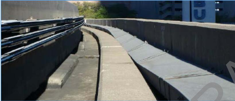
**FIGURE 40: EXAMPLE OF POWER RAIL & CABLE TRAY ALONG GUIDEWAY**
